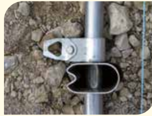
Verankerungsschelle neben jedes Bodenkreuz
