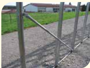
Anbringen der Diagonalstreben
