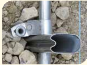
Schlaganker bis zur Schelle versenken
