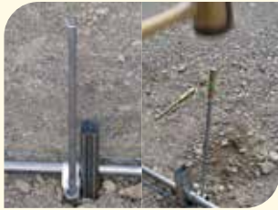
Erdnägel in die Verankerungsschelle und anschließend versenken
