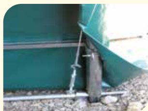
Befestigung des Stahlseils
