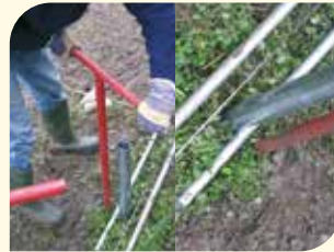
Einschrauben der Bodenverankerung
