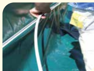
Einschlagen der Klemmprofile
