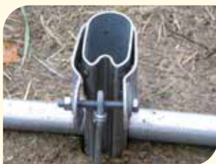
montierte Schraubverankerung
