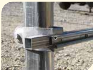
Aufschrauben der Klemmschiene auf die Profilschiene
