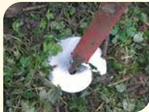
Eindreihen des Schraubtellers
