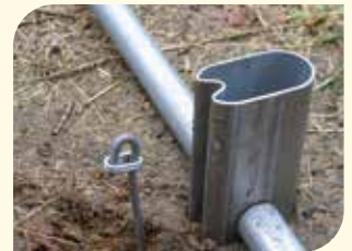
Montage der Sicherungslasche
