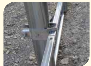
Anbringen der Profilschiene
