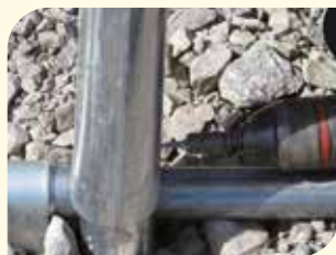
Verschraubung zwischen Bögen und Bodenkreuzen
