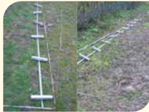
Verteilung der Bodenverankerung
