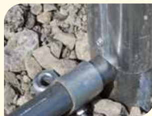
Verschraubung zwischen Bögen und Bodenkreuzen
